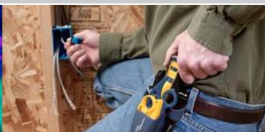
Couper, dénuder et raccorder le câblage en cuivre
