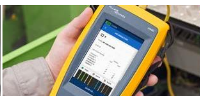
Vérifier le commutateur et la connectivité réseau
