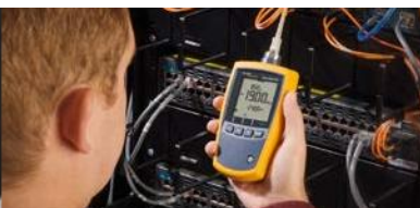
Mesurer les niveaux de puissance et les pertes de la fibre optique
