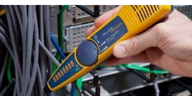
Identifier et tracer les câbles de cuivre
