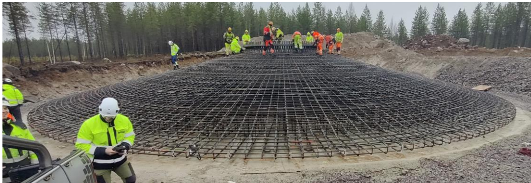
(Figure 5 : Test de la mise à la terre des fondations des éoliennes avec la série GGT)
